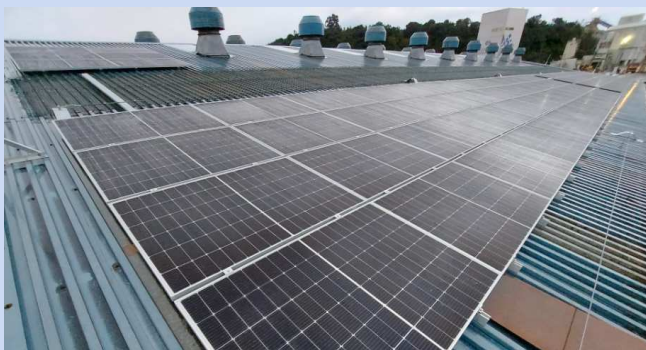
Placas del centro de Herrera de Camargo
